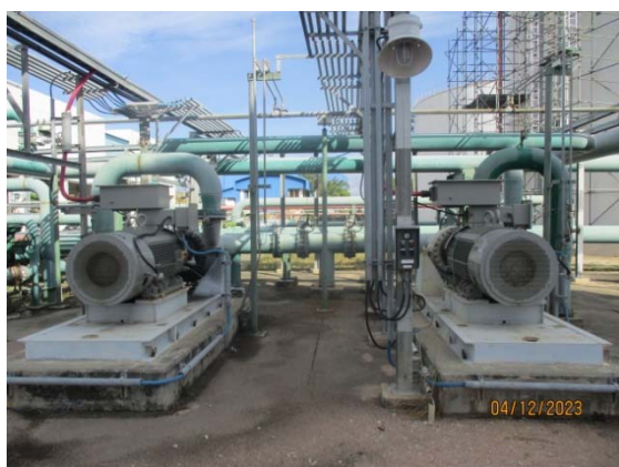
รูปที่ 58 Electric Jockey Pump
