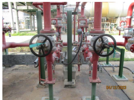
รูปที่ 47 Deluge Valve System
