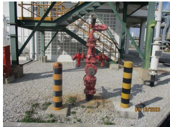
รูปที่ 46 Water Hydrants with Monitors
