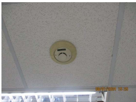
รูปที่ 54 Smoke Detector
