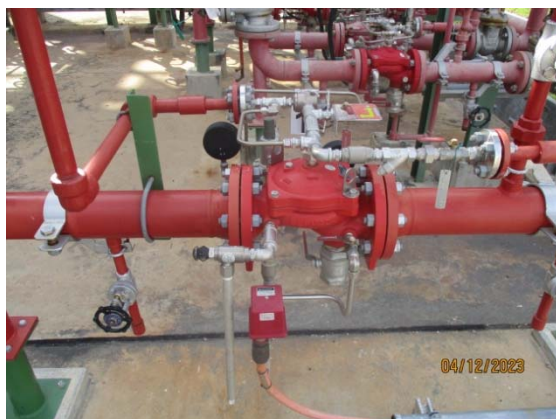
รูปที่ 47 Deluge Valve System
