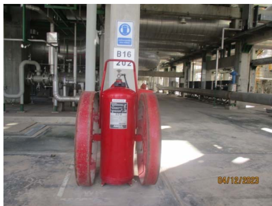
รูปที่ 49 Wheeled Fire Extinguisher
