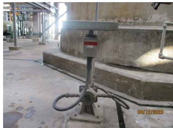
รูปที่ 42 Fixed Gas Detector
