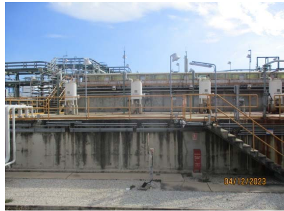
รูปที่ 8 ถังปรับเสมอ (Equalization Tank)
