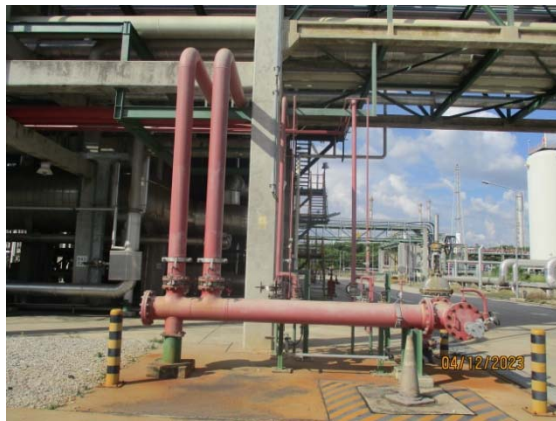
รูปที่ 45 Wet Spray System
