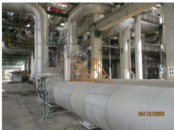
รูปที่ 5 ติดตั้งวัสดุดูดซับเสียง
