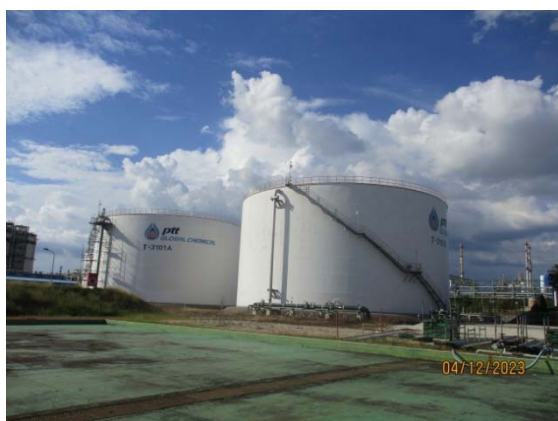
รูปที่ 56 Fire Water Tank (15,000 m 3 )
