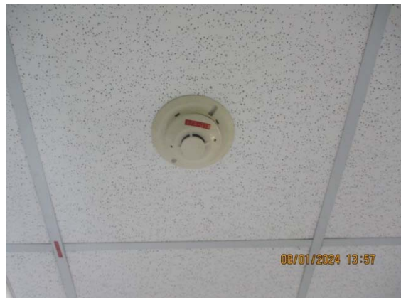
รูปที่ 30 Heat Detector
