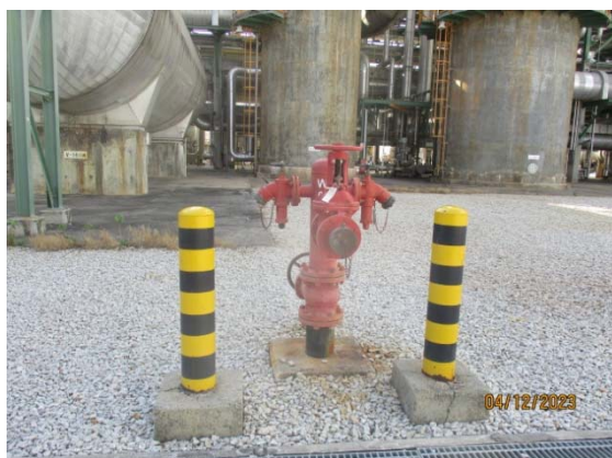
รูปที่ 50 Water Hydrants (Indoor & Outdoor)
