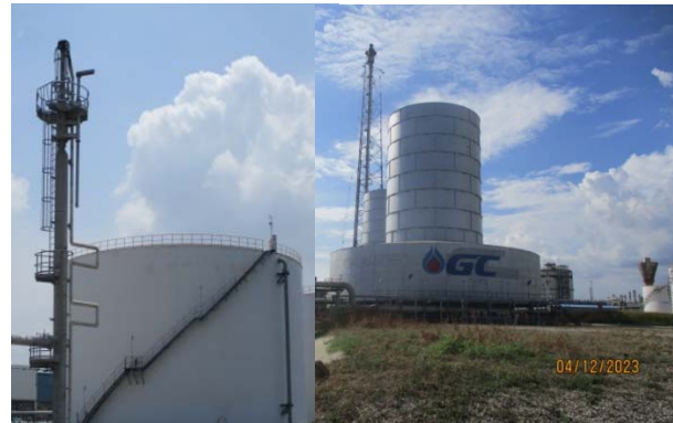
รูปที่ 4 หอเผาความดันต่ำ หอเผาความดันสูง และหอเผาชนิด EGF
