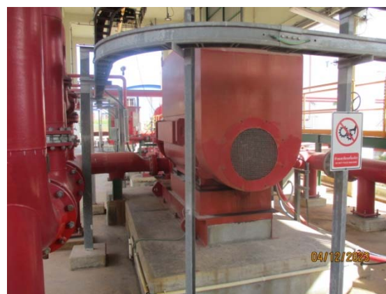
รูปที่ 57 Electric Fire Pump
