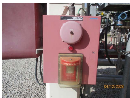
รูปที่ 53 Manual Fire Alarm
