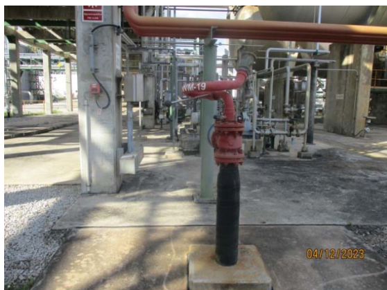
รูปที่ 48 Water Fix Monitor
